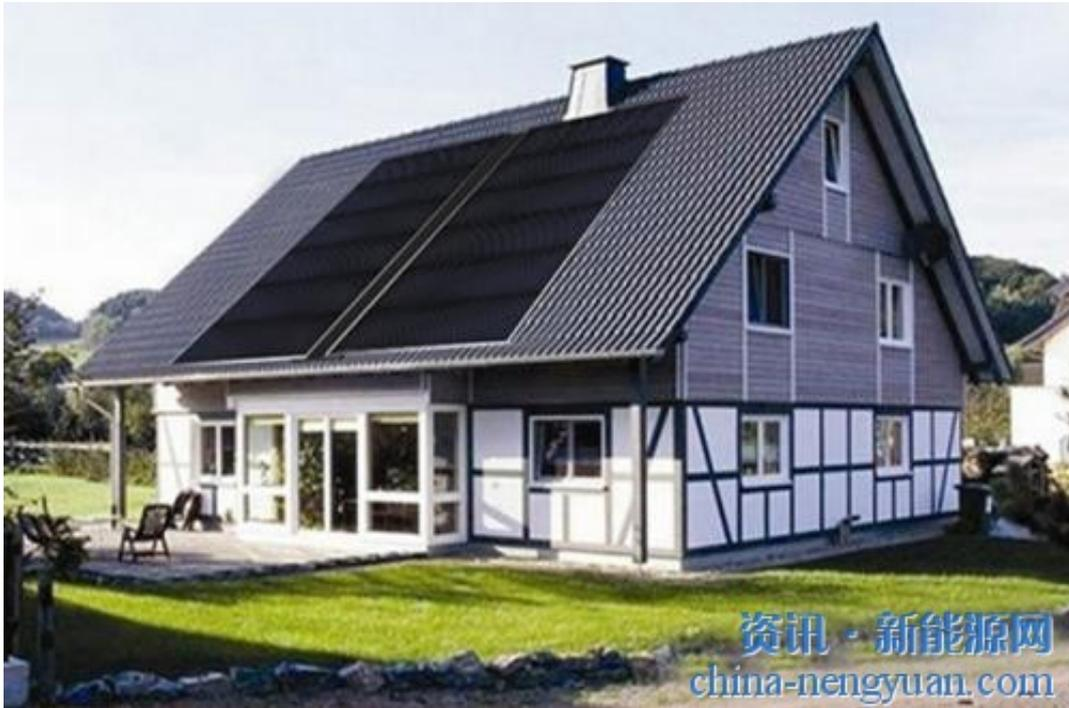
柿子公司最新建筑构件已经面世了，图为太阳能异聚态热利用系统中的异聚态节能建筑构件，将聚热板与建筑屋面一体化设计能够很好的解决传统热利用系统的安装问题，同时把聚热板作为一种建筑元素和建筑融为一体，能够很好的把闲置的屋面加以利用，利用闲置的屋顶开发太阳能热利用，不仅有效推动了再生能源的开发利用，同时产生的环境与社会效益十分可观，对推动生态文明建设具有重要意义。
