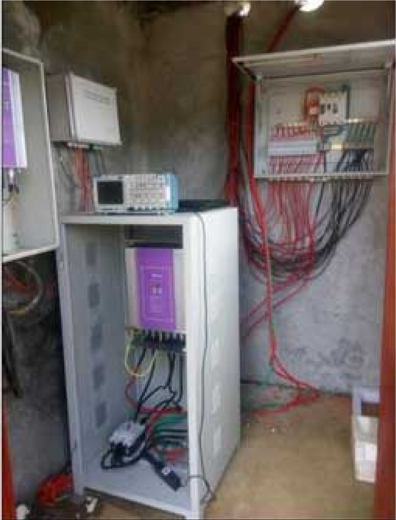
太阳能光伏提水系统农田作物灌溉
