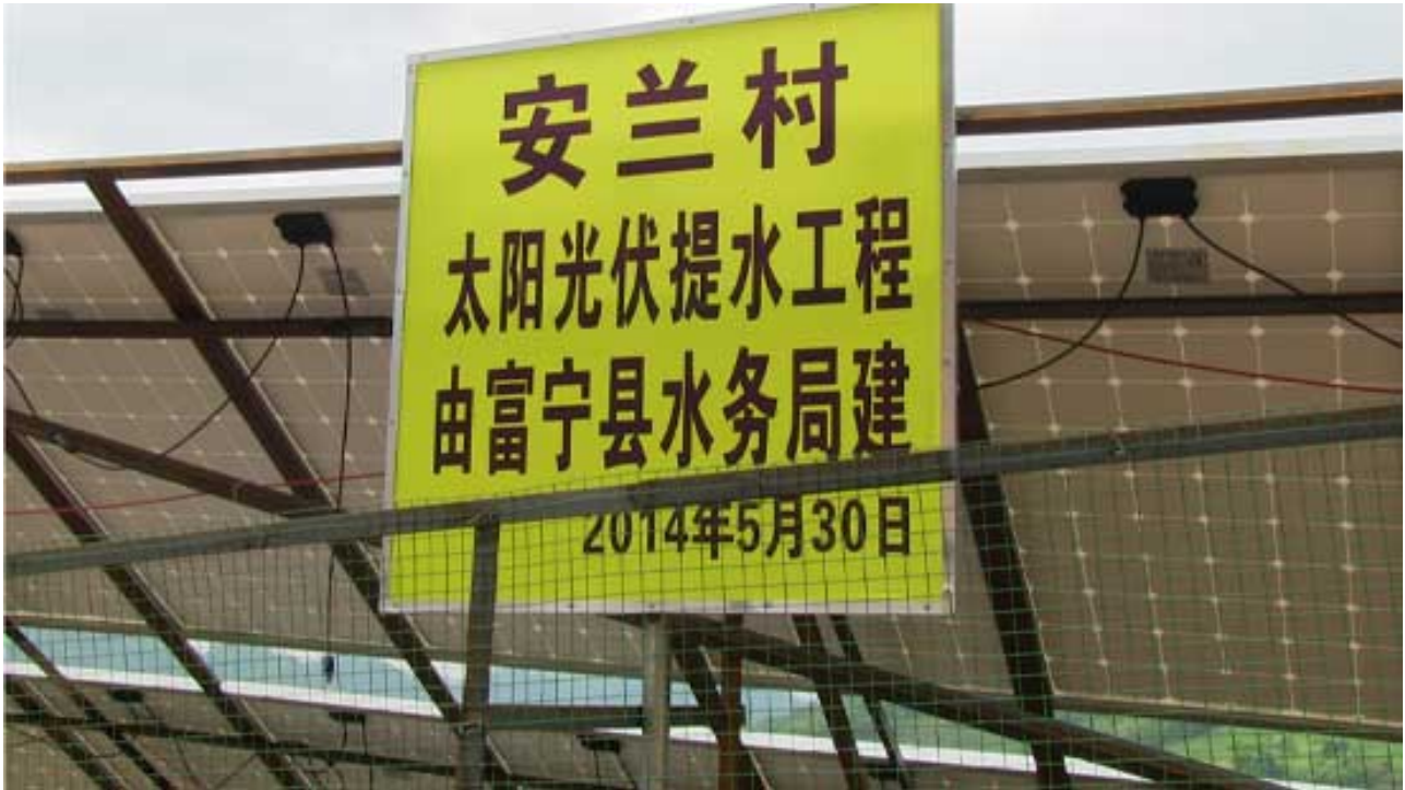
富宁县水务局筹资建设光伏提水工程
