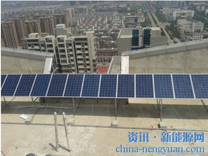
近日，宿迁金融财富广场14KW太阳能并网发电系统项目成功安装完成，项目位于金融财富广场B、C座顶楼，现已进入并网阶段。该商业项目是由中电电气光伏易开发承建，安装面积合计约140平方米，年平均上网电量两万多度。据介绍，此项目享受国家0.42元/度的补贴，预计7年左右即可回本，
