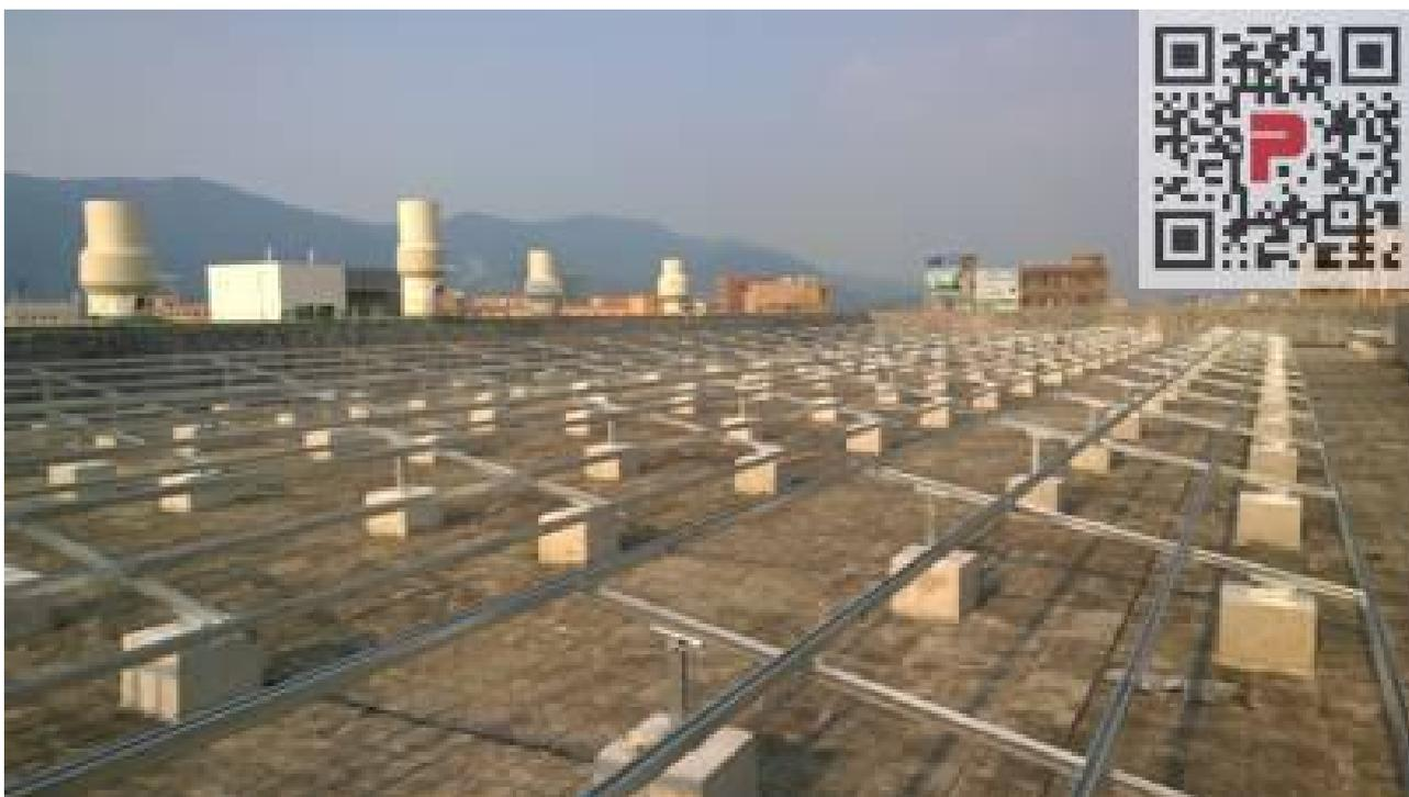
这个4.3MW项目位于龙溪电镀城，分布在25个屋面，采用的是保威水泥基础屋面光伏支架系统。针对电镀城的空气环境含酸成分较高，保威提高了光伏支架的表面锌层厚度，比常规项目高出20 $\mu$ ，确保防酸性能，保证电站的25年使用寿命。
