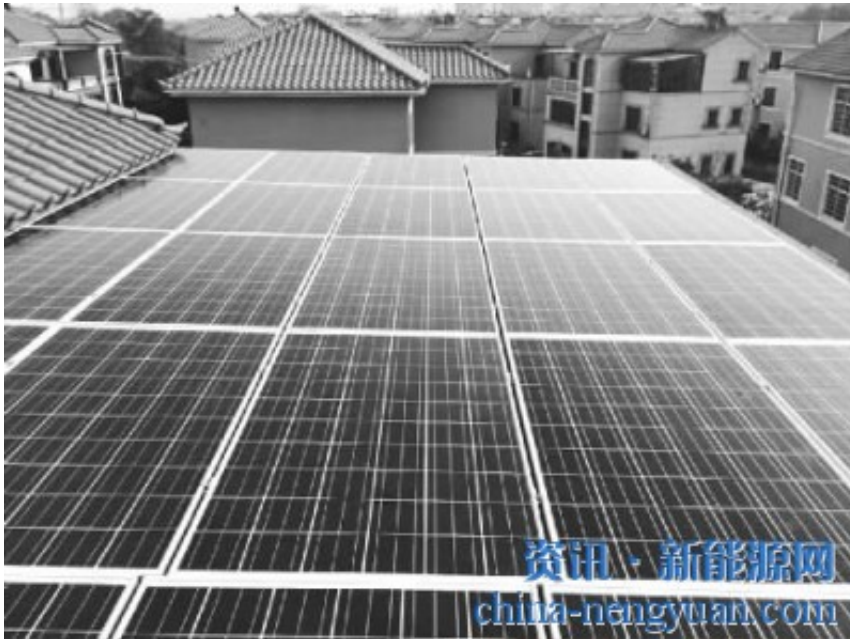
图为张家界市首个居民分布式光伏发电项目并网成功。
