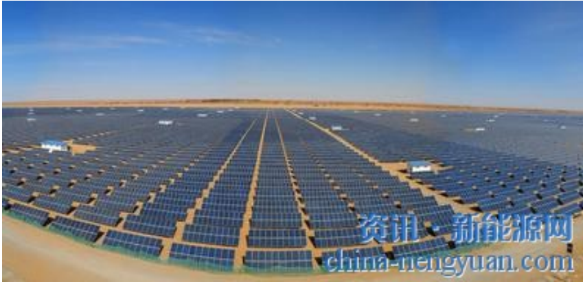
东方日升新能源股份有限公司中国内蒙古15MW项目
