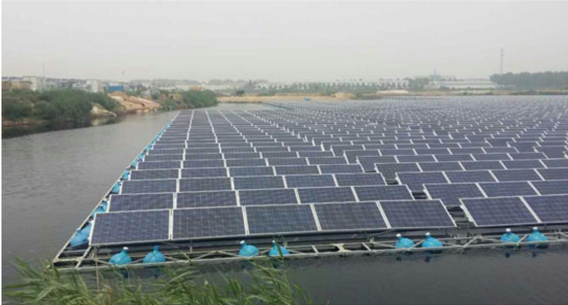
整个项目全部选用易事特自主研发设计的1MW集成式光伏电站系统解决方案，采用分块发电、集中并网、集中控制方案，将系统分成8个并网发电单元，分别经直流汇流箱、逆变器升压后汇接至光伏电站最终实现并网。尤其值得一提的是该项目采用了朗禾公司的可移动式拼接构件和水面漂浮型的支架，可以随时灵活的移动区域，同时通过岸边的锁链进行牵引固定，不受水位高低的影响。在蓄水期和排洪期不会对湖泊或水库造成阻碍也不会影响其自身的发电。
