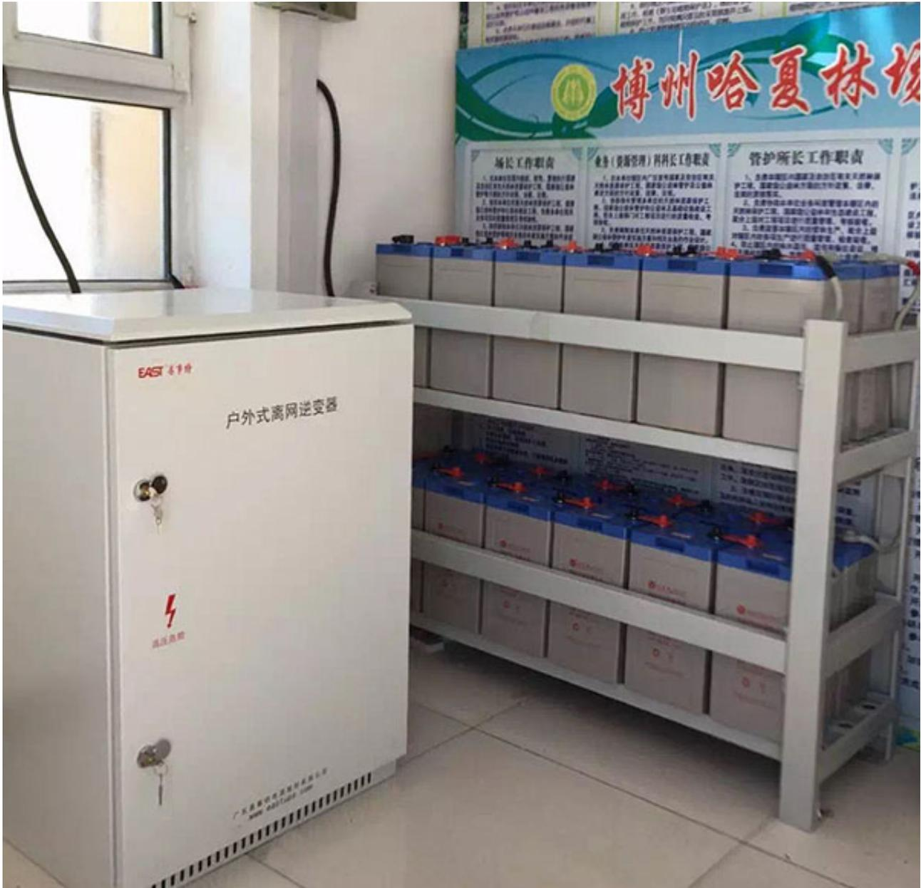
为帮助边远林场告别无电生活，根据国家能源局制定的《全面解决无电人口用电三年行动计划》，新疆自治区开始实施光伏独立供电工程来解决边远林场无电人口用电问题。结合边远林场守护站的实际情况，易事特专门为哈夏林场提供了户外离网型分布式光伏发电系统解决方案。该方案的核心设备为太阳能一体式离网逆变器，是公司根据绿色能源的利用、偏远地区设备用电的需要研发的，再配上电池储能系统，不论白天、黑夜都可以为守护站的工人们提供日常生活用电，而且还可以保障各守护站的安防监控及边防通讯系统的正常用电。
