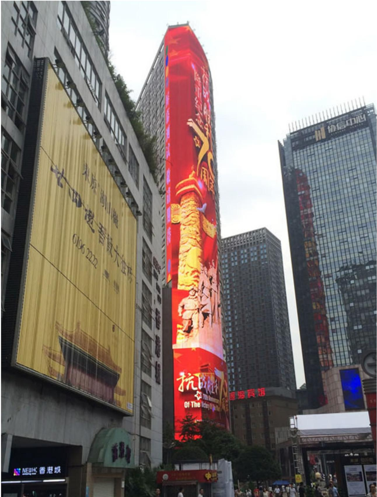
其中，有“亚洲第一户外LED显示屏”之称的重庆观音桥茂业大厦项目获得本届OFweek LED Awards 2015“最佳LED显示屏工程案例奖”。据悉，该项目是重庆观音桥商圈斥资4000万重点打造的形象提升工程，由全球领先LED应用产品与解决方案提供商——洲明科技承建，面积达3363平方米，高度超过100米，刷新了户外LED显示屏之最。该项目的过人之处还在于所采用的洲明LED格栅屏具备超薄轻透、防风压，重量仅为15~18Kg/m<sup>2</sup>，只有普通显示屏1/6等特
