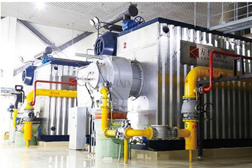
北京怀柔平安热力雁栖供热站 FGR 水管锅炉 NOX 24ppm
