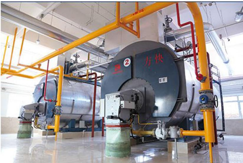
北京怀柔平安热力富乐园供热站 FGR 一体冷凝热水锅炉 NOX 20ppm
