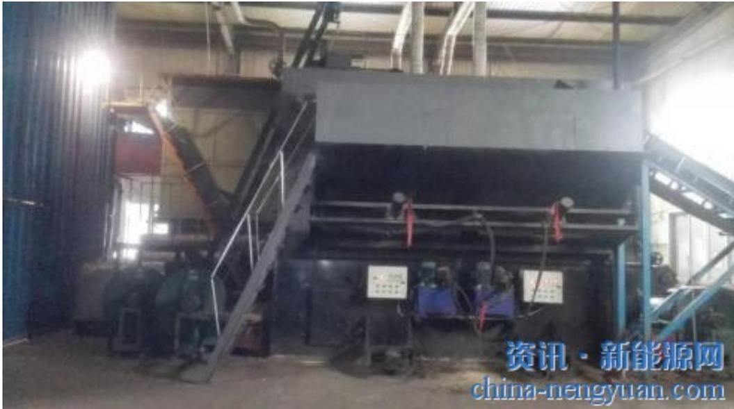
我公司为济南市槐荫区的济南新峨眉实业有限公司的10吨链条燃煤锅炉进行高温气化改造。改造前，烧5500大卡颗粒煤，每小时烧1.3-1.4吨，改造后烧3800大卡生物质颗粒，每小时烧1.3吨就能产同样多的蒸汽。
