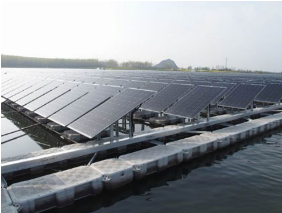
图五：水上漂浮光伏电站场景。
