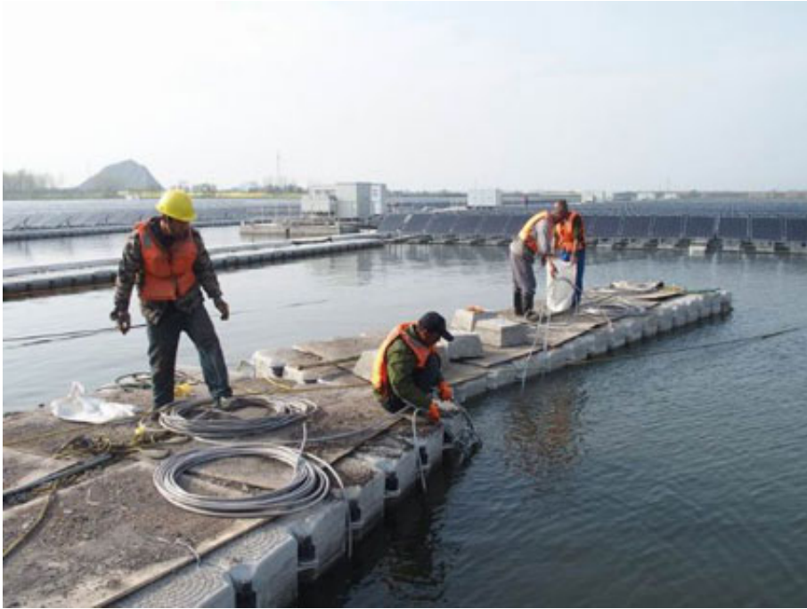
图三：工人们在水面上施工。
