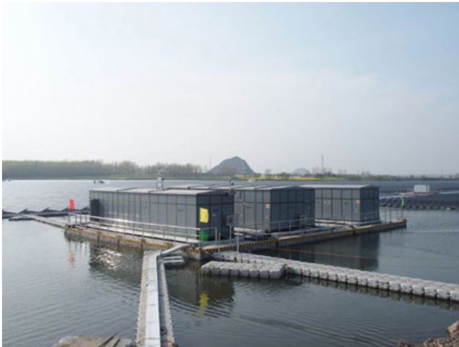
图四：光伏电站发电将在这里升压至35KV出线到望峰岗变电所。
