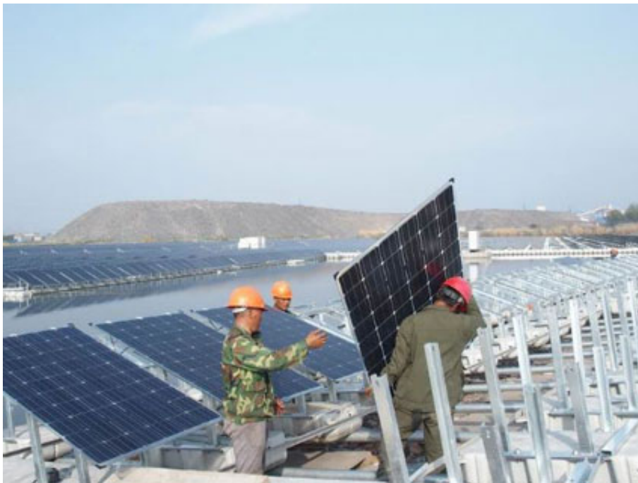
图二：后继施工中，工人们把光电板安装到漂浮平台上。
