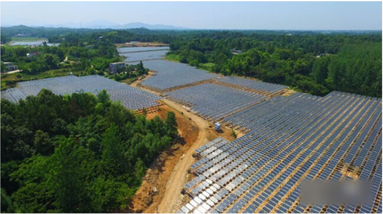
金寨6MWp农光互补智能光伏电站
