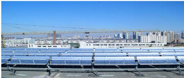
传奇电气（沈阳）有限公司槽式太阳能采暖、工业用热项目实景图 2
