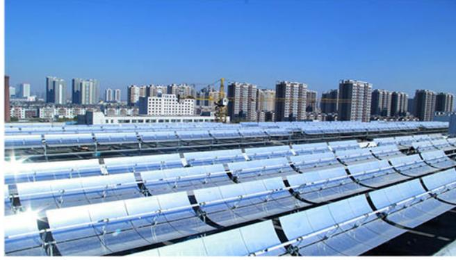
传奇电气（沈阳）有限公司槽式太阳能采暖、工业用热项目实景图 1
