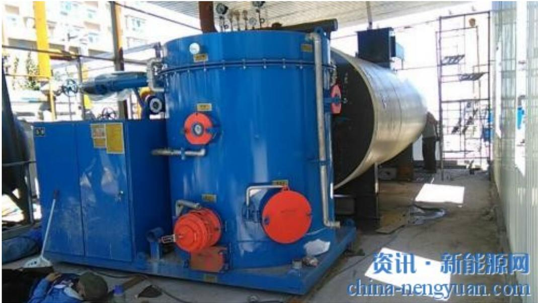
近日，我司于山东某化工产业对接配套用在四吨导热油炉上的海琦生物质燃烧机，现场安装调试完工。
