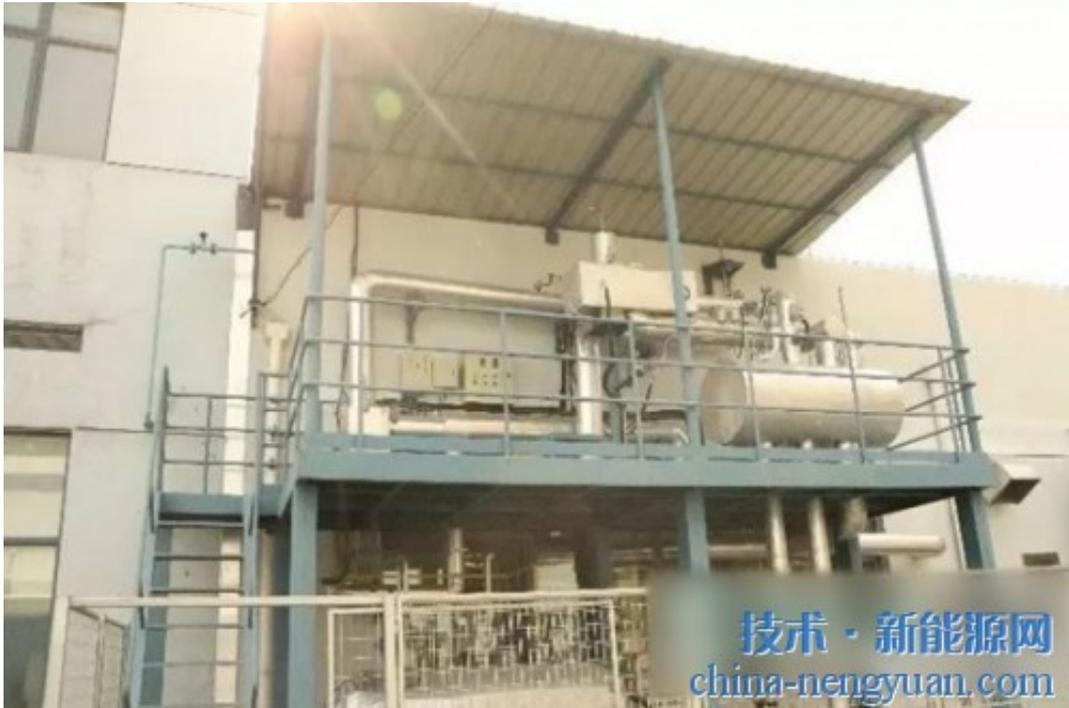
通过本项目建设的高温双罐熔盐储热示范系统，模拟了光热电站的熔盐储换热系统，测试了熔盐管内对流换热系数，积累了熔盐系统启停及运维经验，目前已为多家企业提供了熔盐物性及腐蚀特性测试等服务，为光热电站熔盐储热系统的设计、建设和运行打下了坚实的基础。该项目在设计/运行温度、防冻堵策略、智能控制等关键性能指标方面均达到了国内先进水平。
