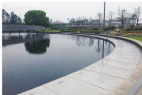
图2 沉淀池降噪盖板实施情况
