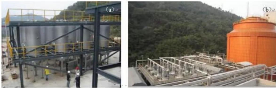
图1 罐体装置图：(a)污泥热水解罐；(b)厌氧消化罐
