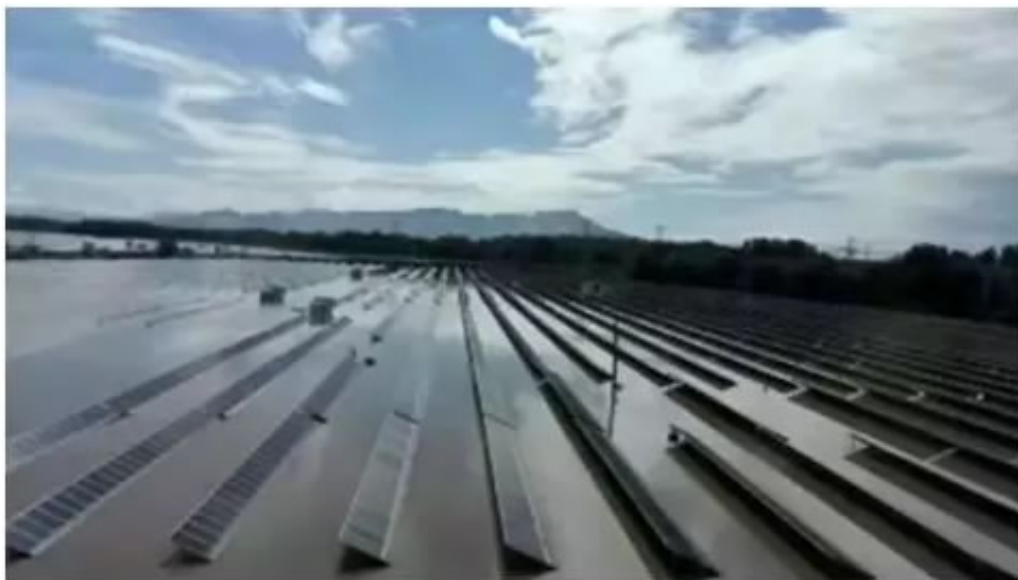
图 6 湖北某光伏电站因遭遇强降雨侵袭
