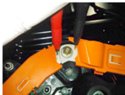
图 3-60 正极 Busbar 与主正继电器 busbar 连接阻抗测量
