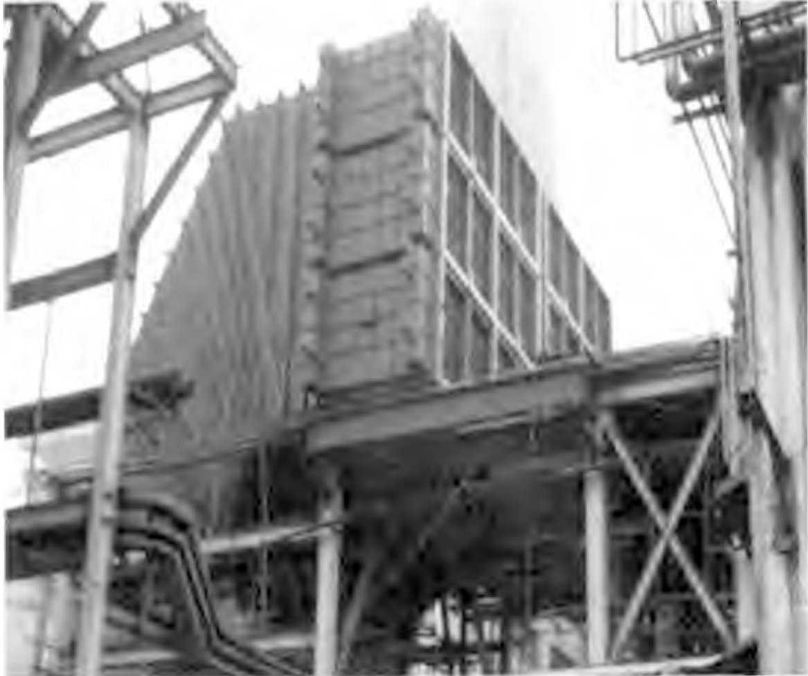
图1 低温省煤器现场安装图
