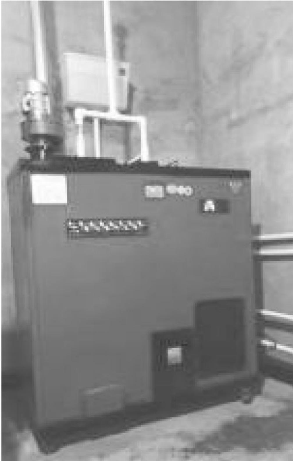
**图 6** 热水式生物质采暖炉
