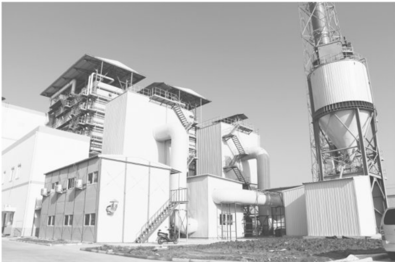
图6 2 \times 45\text{t} \cdot \text{h}^{-1} 多流程循环流化床生物质锅炉
