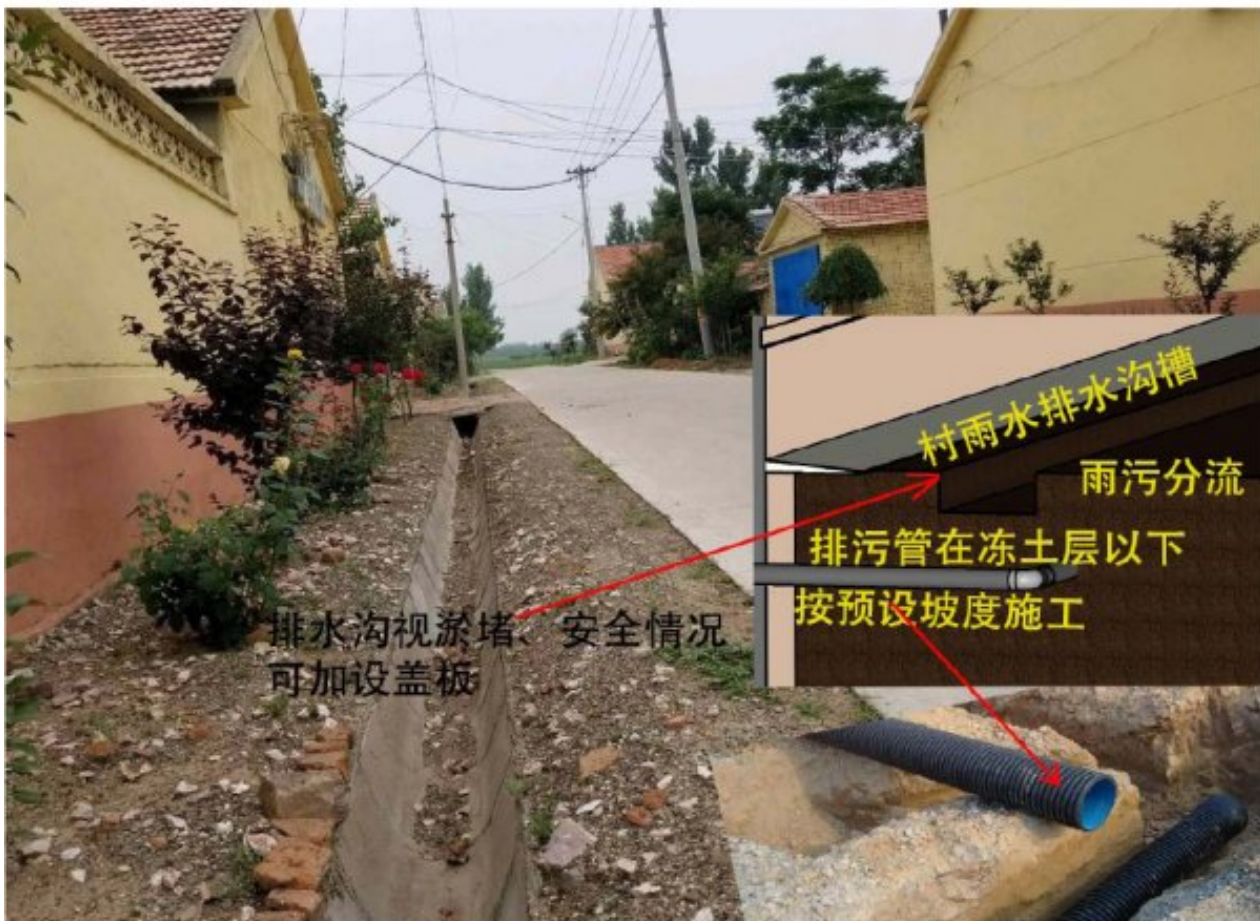
b. 村路边雨污分离沟渠示意图
