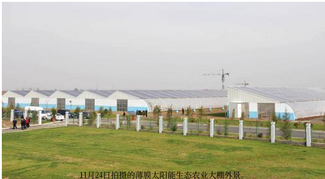
11月24日，工作人员在薄膜太阳能生态农业大棚顶上进行清洗作业。
