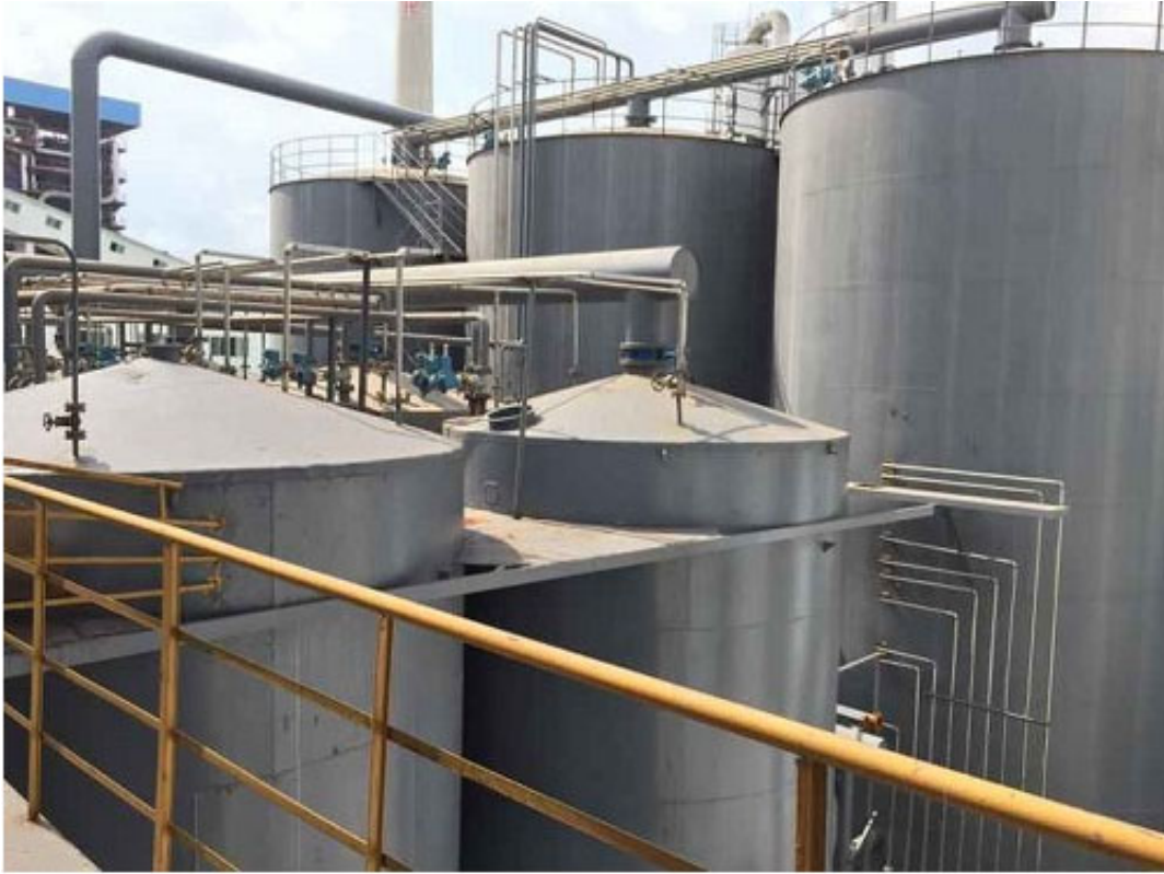
示范工程现场
