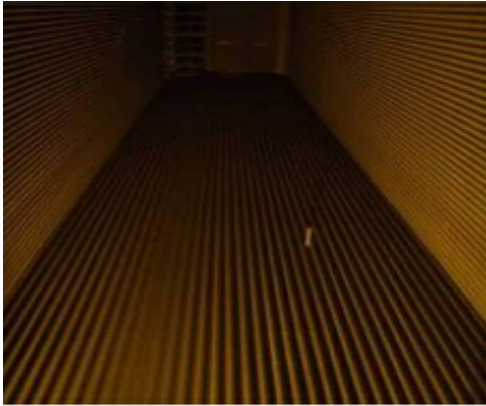
图5 炉内水冷壁结渣情况
