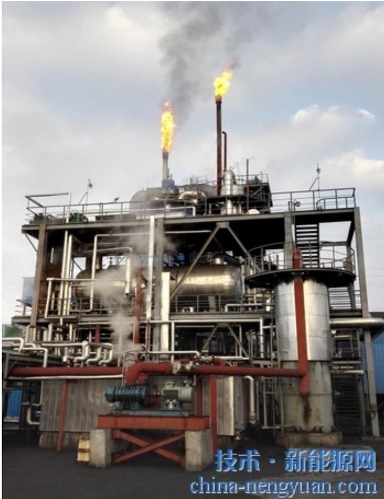
近日，中国科学院工程热物理研究所科研人员经过数日调试，240吨/天固体热载体煤低温热解中试装置实现满负荷稳定运行，这是国内首次实现10万吨/年规模的循环流化床粉煤热解装置满负荷运行，为中科院战略性先导科技专项“低阶煤清洁高效梯级利用关键技术与示范”又一重要进展。
