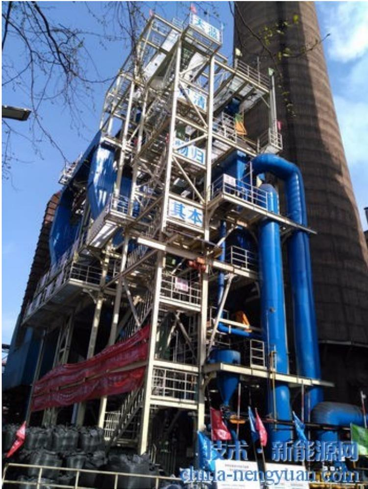
近日，中国科学院山西煤炭化学研究所与北京国能中电节能环保有限责任公司在山东钢铁股份有限公司济南分公司合作开展的25000Nm<sup>3</sup>/h烟气多种污染物干法一体化脱除工业示范试验成功。
